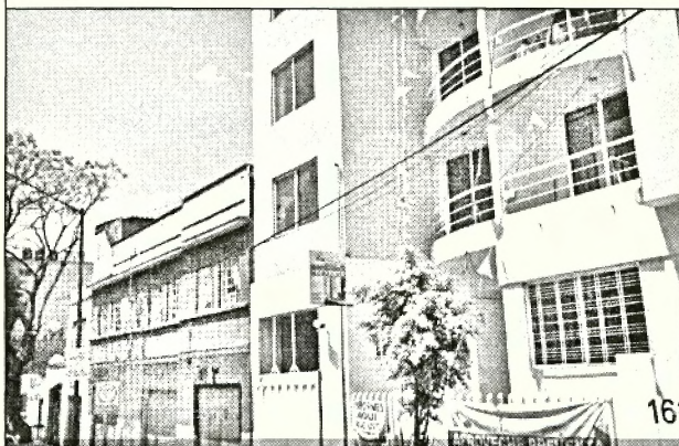
Fotografía 1. Edificio en la colonia Independencia
