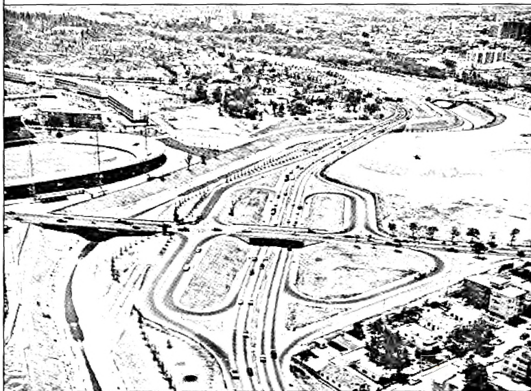
Fotografía 1. Autopista del Este. Distribuidor Plaza Venezuela
