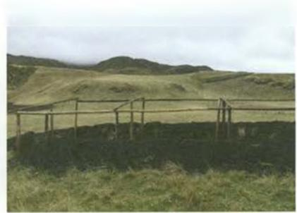
Foto 52. Levantamiento de la estructura de madera que sostendrá el plástico del invernadero
