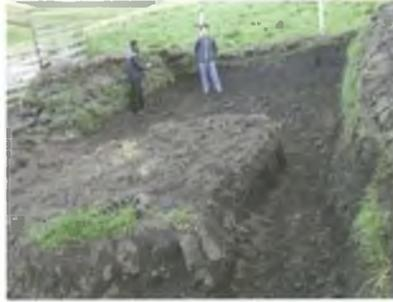
Foto 51. Proceso de cavado y extracción del suelo para nivelar el lecho del invernadero
