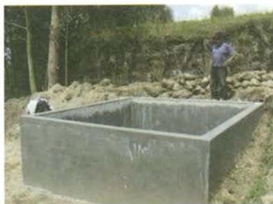
Foto 75. Reservorio de concreto para riego de un predio familiar en Pulingul
