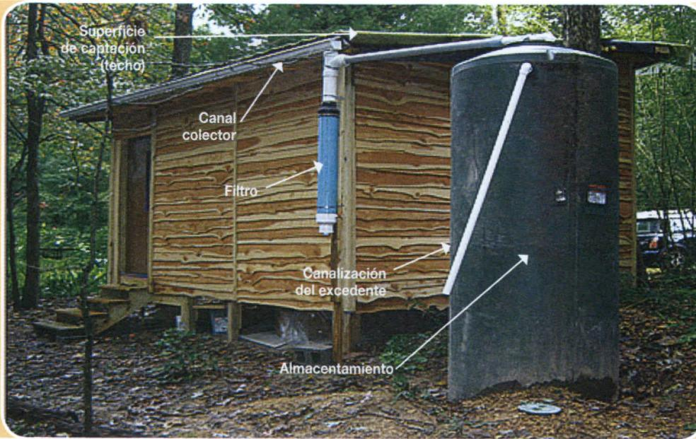
*Componentes de un sistema de captación de agua de lluvia.*
