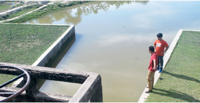
4 Imagen: © REACH | Tecnología de polder para gestionar el agua en zonas de avance costero.
