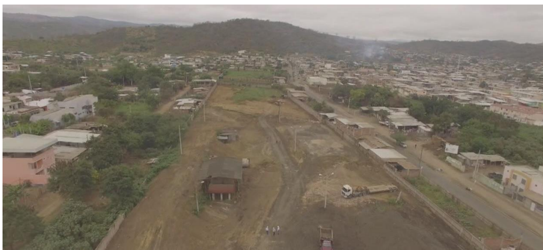
Fotografía N° 4. Terreno previo a la construcción del proyecto
