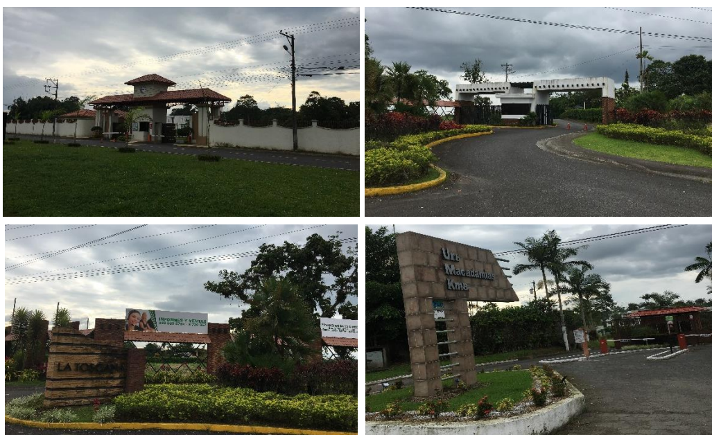
Fotografía N° 3. Entrada a urbanizaciones cerradas en la Vía Chone
