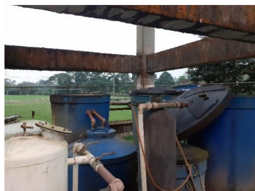
(b) Acometida de agua, al abrirla se obtuvo un agua turbia, de color blanquecino y ligeramente espesa
