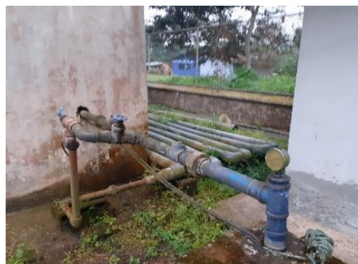
(b) Acometida de agua, al abrirla se obtuvo un agua turbia, de color blanquecino y ligeramente espesa
