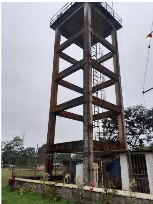
(a) – Estructura del reservorio-torre de agua de Chigüilpe
