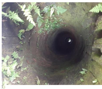
(b) Interior del pozo de agua
