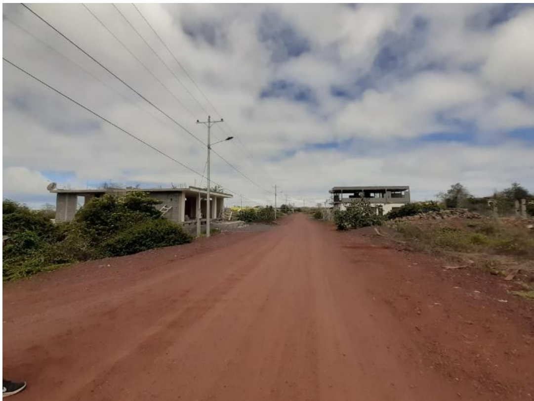
Fotografía N° 4. Desnivel de la vía y lote constructivo
