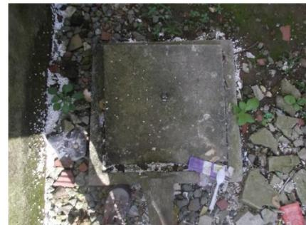
Fig 15 Detalle de la caja de pasaje de aguas servidas ubicada en el piso externo en la lateral derecha de la casa
