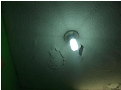
Fig. 12 Evidencias de infiltraciones de agua del departamento superior en la losa de techo del baño
