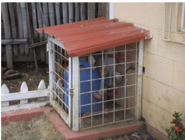
Fig. 15 – equipamiento instalado en las casas para filtración del agua.
