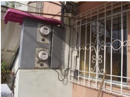
Fig. 14 Detalle de los medidores de energía de la casa inferior y de la superior
