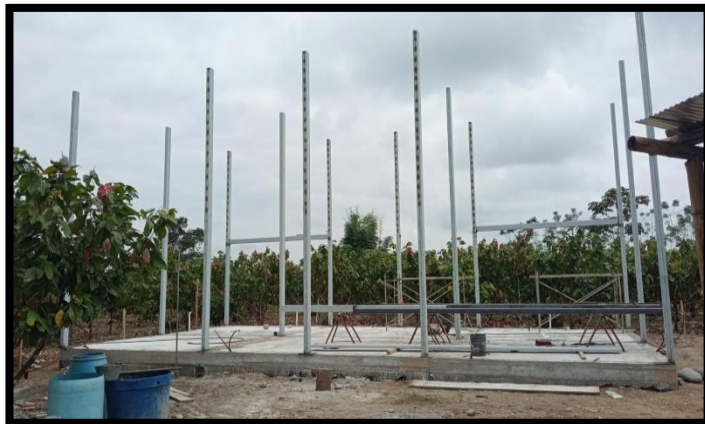
Foto 3.1113. Materiales de construcción de segundas residencias
