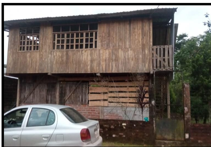
Foto 3.7.10 Materiales de construcción de vivienda de la población local
