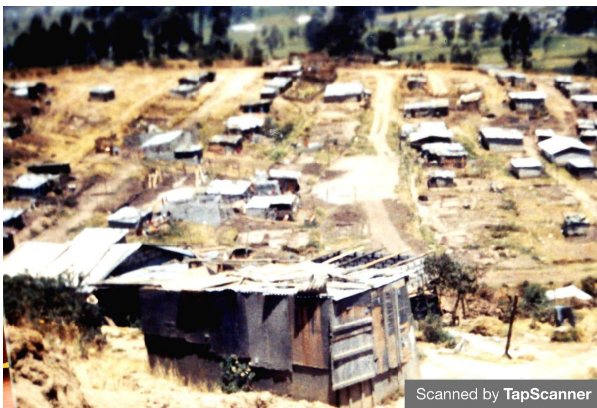
Foto 4.2. Antiguas viviendas del barrio
