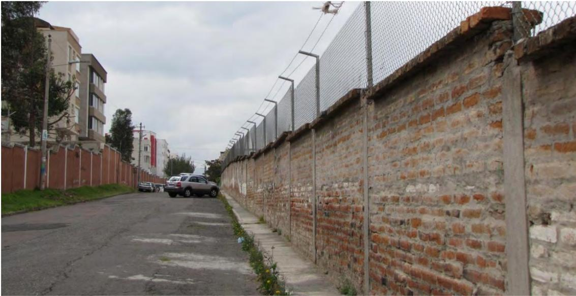
Figura 27. Los muros de las urbanizaciones son ampliados generalmente con mallas metálicas o sistemas electrificados.
