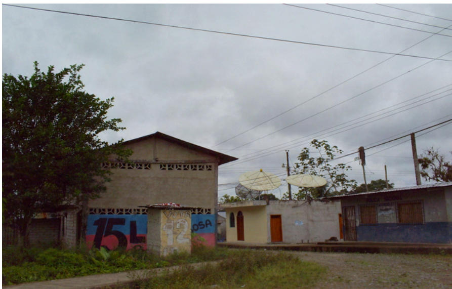
Antenas de televisión por cable instaladas en Carondelet
