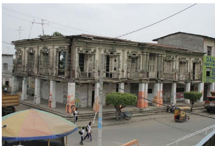
Antiguo Municipio de Vinces en estado crítico de deterioro, 2007.
