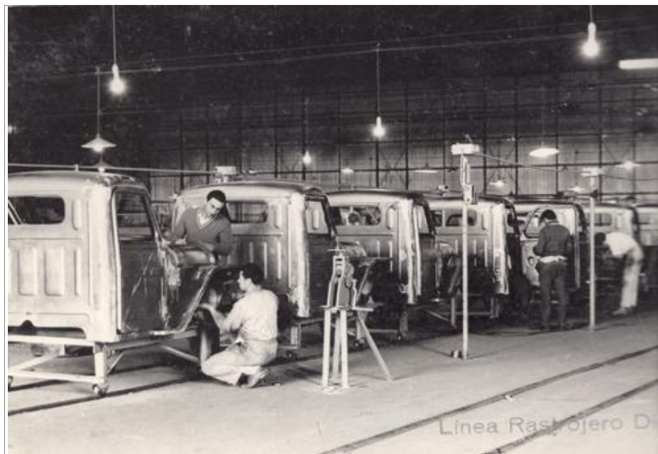
Foto N° 19 – Línea de montaje de la cabina del Rastrojero
