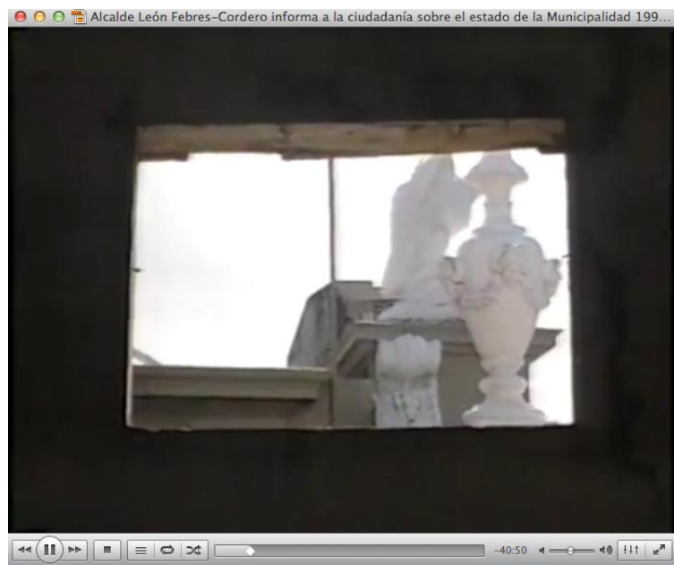
Fotograma 3: En el mismo video muestran un agujero en la pared donde existía un aire acondicionado. Se indica que “todo lo que se pudo desprender del suelo o del techo se lo han llevado”
