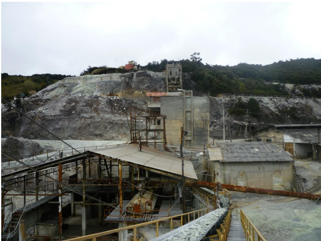
Foto 8: Mina de azufre El Vinagre, sector de trituradora y bandas transportadoras.
