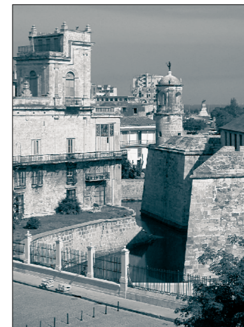
Castillo de la Fuerza y Palacio del Segundo Cabo
