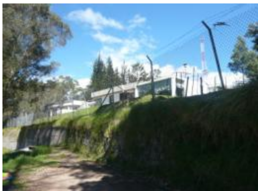
Instalaciones de la EPMAPS
