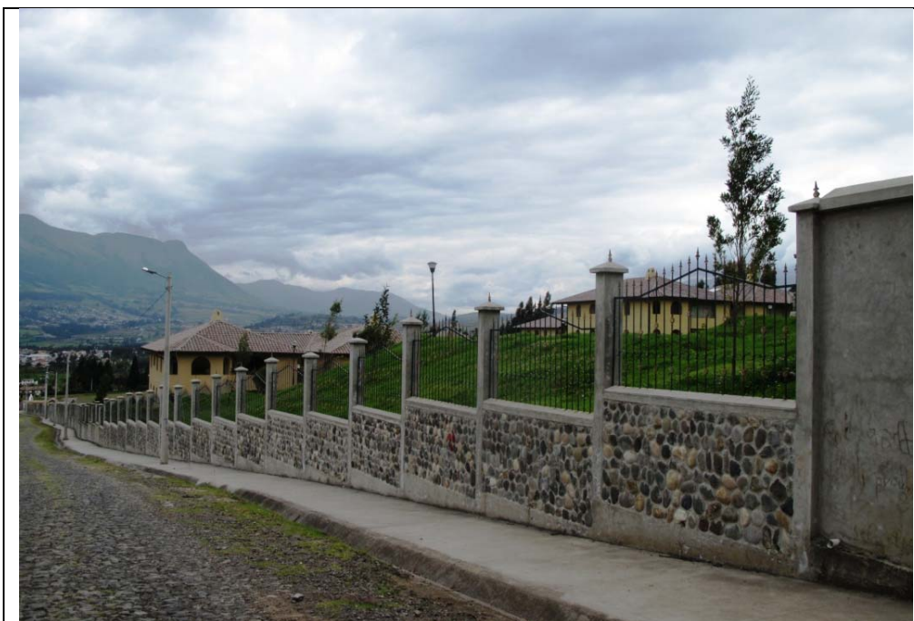
Foto No. 18. Vista lateral del cerramiento - Conjunto Residencial "Jahua Paccha" Fuente: Visitas de campo, 2014.
