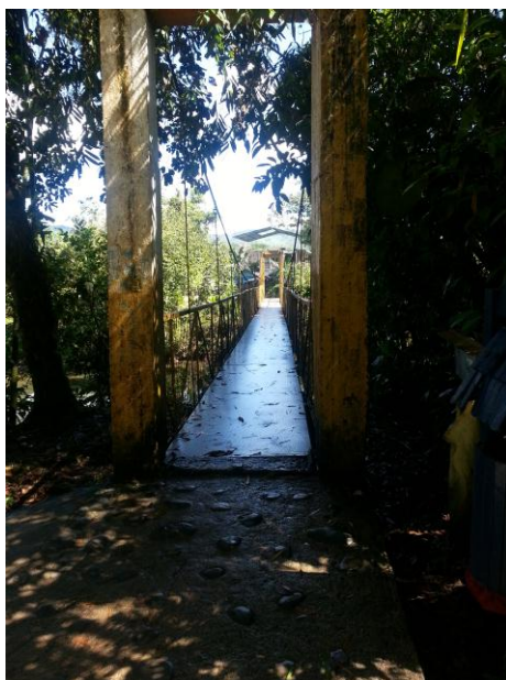
Imagen 1: Puente colgante parte del Paseo Turístico del río Puyo Fuente: Contreras, 2013.
