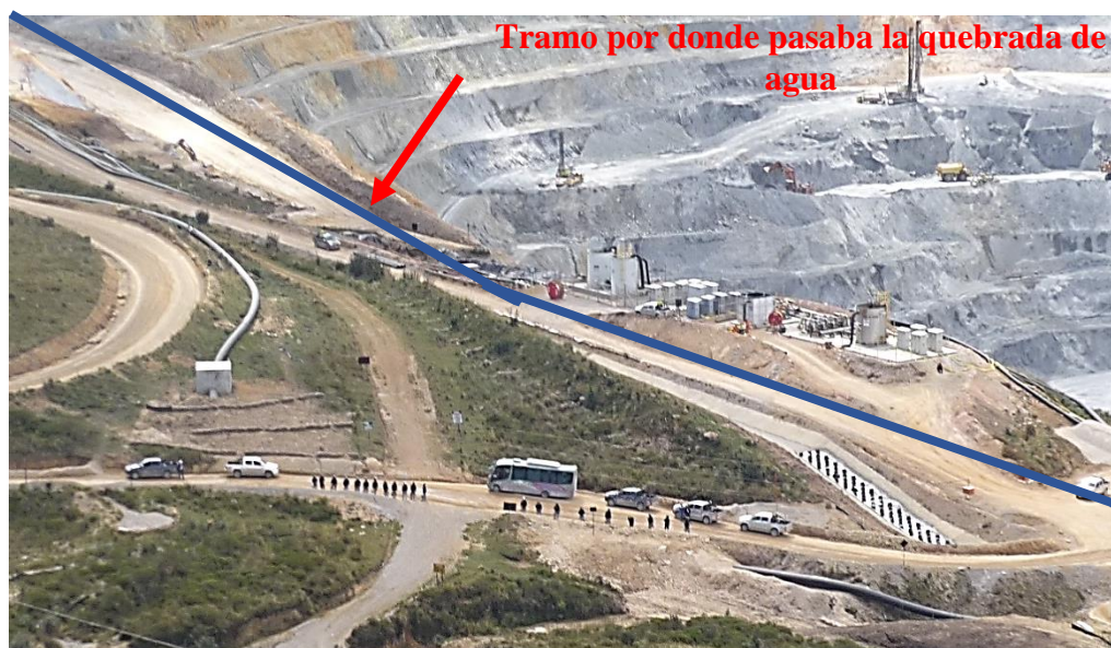
Fuente: Luis Huamán (Alteración de la quebrada y traslado del agua por mangueras) Figura: 5
