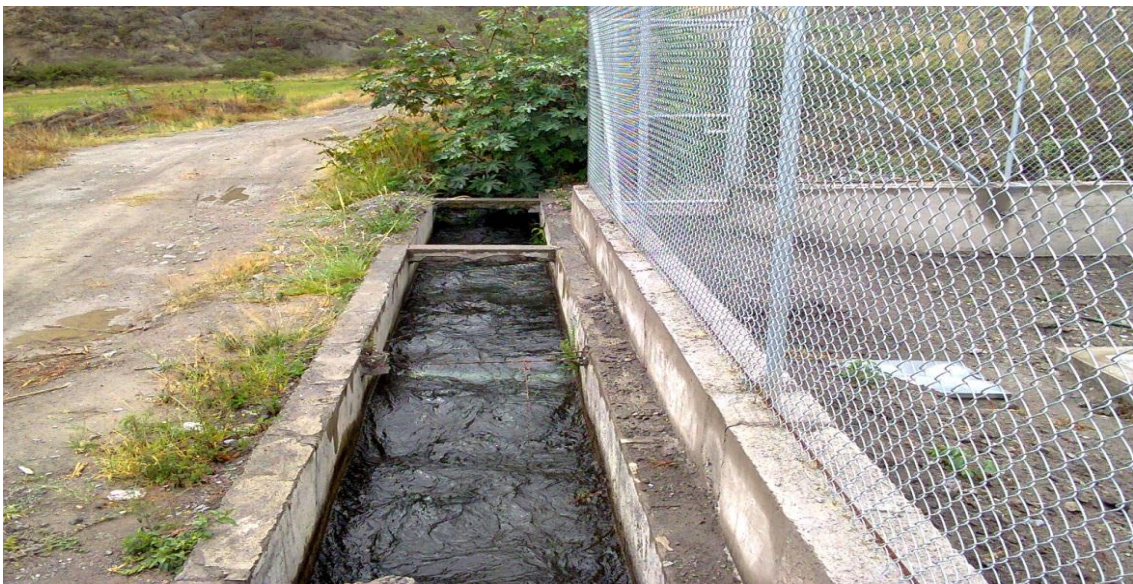
Fuente: Fotografía Marco Villa (Canal de riego para comunidades del Valle del Chota)
