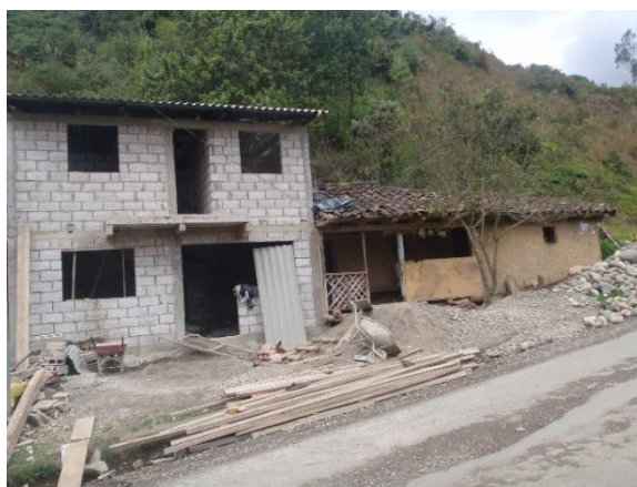
Foto 28. Fuente: Fernando Lucero. Construcción de vivienda sector Chalacay
