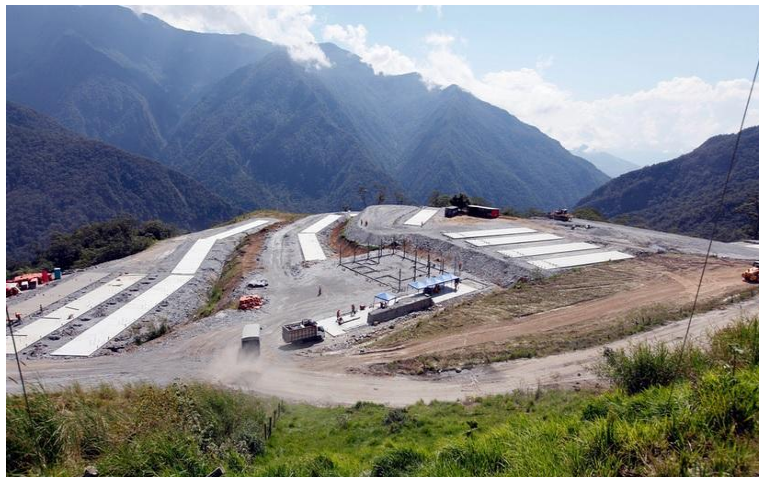
Foto 5. Fuente: Presidencia de la República 18 . Construcción Proyecto Sopladora
