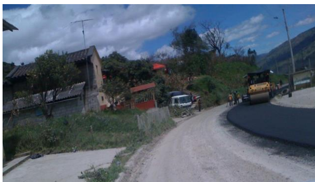
Foto 29. Fuente: Román Castro. Proceso de construcción de la vía panamericana
