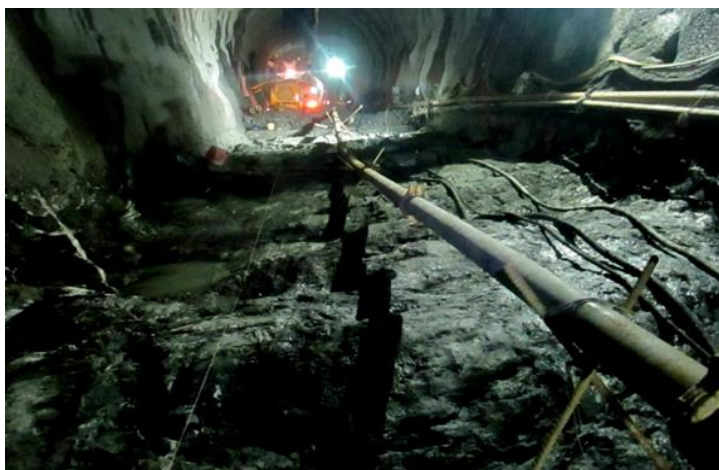
Foto 2. Fuente: Ministerio de Electricidad y energía renovable 12 . Túnel de Carga V1. Proyecto Sopladora
