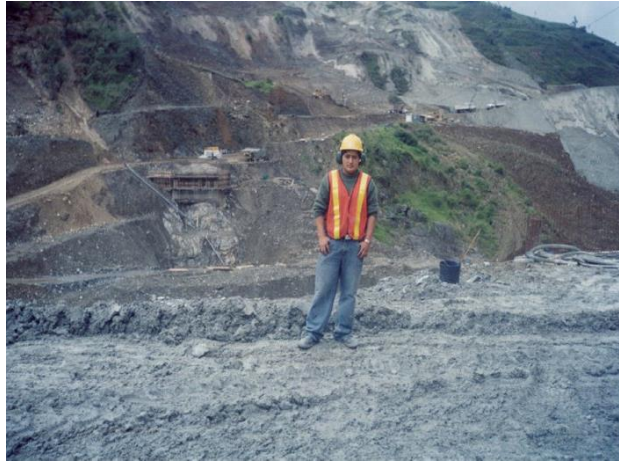
Foto 27. Fuente: Aldo Castro. Trabajos de construcción, proyecto Mazar
