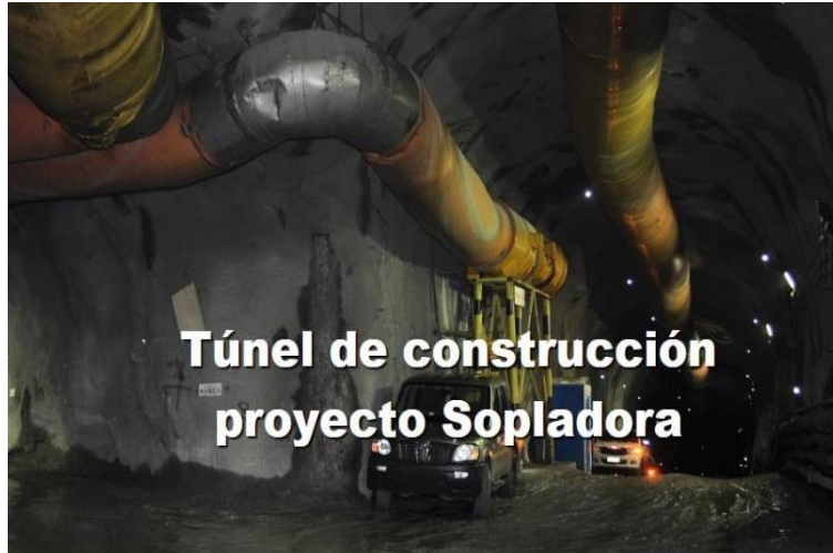
Foto 4. Fuente: CELEC- EP 17 . Túnel Proyecto Sopladora
