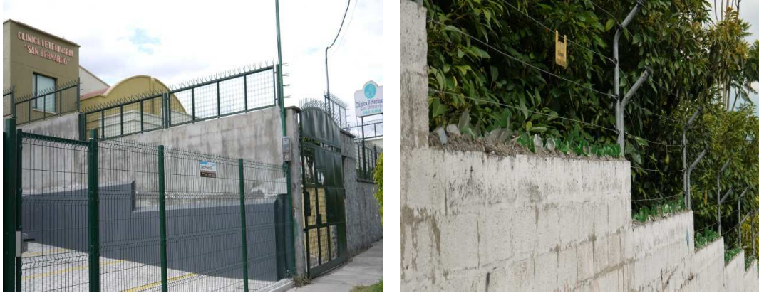
Foto- Collage, No. 9, Clínicas veterinarias ultra seguras y Muros defensivos por altura, vidrio, cerca electrificada y vegetación, Cumbayá. Fuente: Santiago Barona M.
