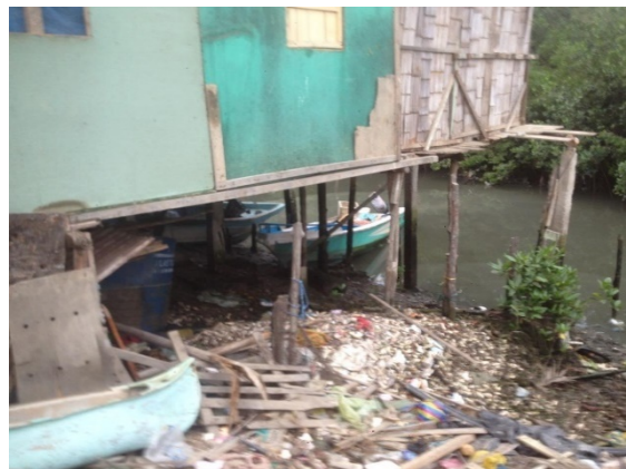
Fotografía 3.1. Aumento de vivienda hacia el estero Fuente: Trabajo de campo
