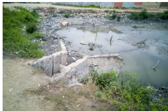
Fotografía 3. 7. Descargas de aguas servidas de la Ciudad, sobre el canal El Macho, en el barrio Manglar del Afro
