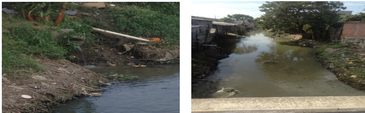
Fotografía 3. 9. Descarga de AA. SS. de la ciudad en otro sector del canal El Macho Fuente: Trabajo de campo
