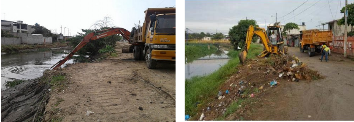
Fotografía 2. 1. Limpieza permanente de Canal El Macho Fuente: Trabajo de campo
