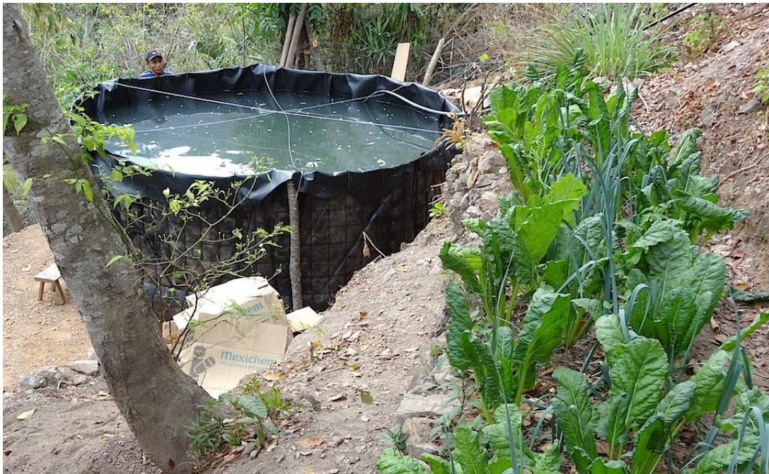
Figura 6. Prototipo de cosecha de agua de lluvia implementado en el Corredor Seco en Guatemala
