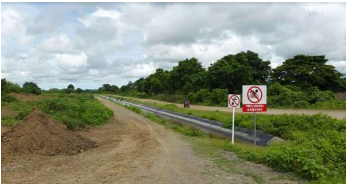
Ilustración 7: Obras complementarias a la rehabilitación de la Represa San Vicente: canales secundarios para traslado del agua desde la Represa a las comunidades. Fuente: Imagen captada por el autor (marzo de 2017)
