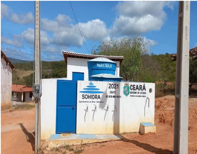
Cisternas para retirada de sal da água. . Recebem água de um poço e passam pelo processo de dessalinização.
