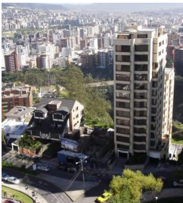
Foto N° 20 - Adriana Luz; final 2007 Antes da construção
