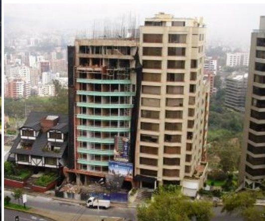
Foto N° 21 - Adriana Luz; final 2008 Construção do edifício, rua Coruña.
