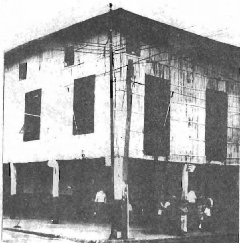
Foto 7 El centro de Guayaquil. Los pilares de madera sostienen las paredes de caña; en la galería cubierta (protección del calor y las lluvias) se encuentran las tiendas; el primer piso está afectado a la vivienda y las grandes ventanas permiten una buena ventilación (foto H. R. GODARD).
