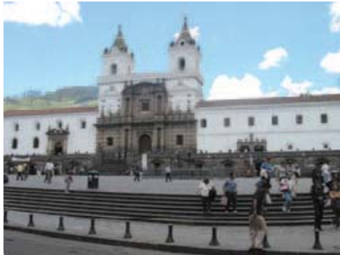
13 - La iglesia actualmente. Se observará que el segundo piso de los companarios no fue reconstruido.
