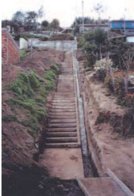
19 y 20 - Pequeñas obras destinadas a mejorar el escurrimiento en los terrenos en pendiente, realizadas en el marco de un proyecto de la ONG Cooperazione Internazionale en 2000, en el barrio Atucucho (antes y después)
