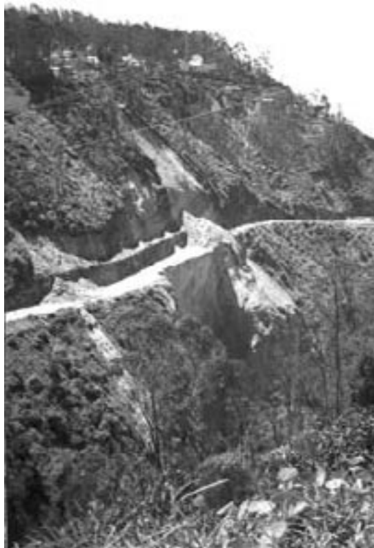
5 - Un eje vial esencial que une la ciudad de Quito a los valles orientales (Vía Interoceánica), cortada por un derrumbe en mayo de 1998. Actualmente se construye un túnel. Foto: F. Demoraes, julio de 2000.
