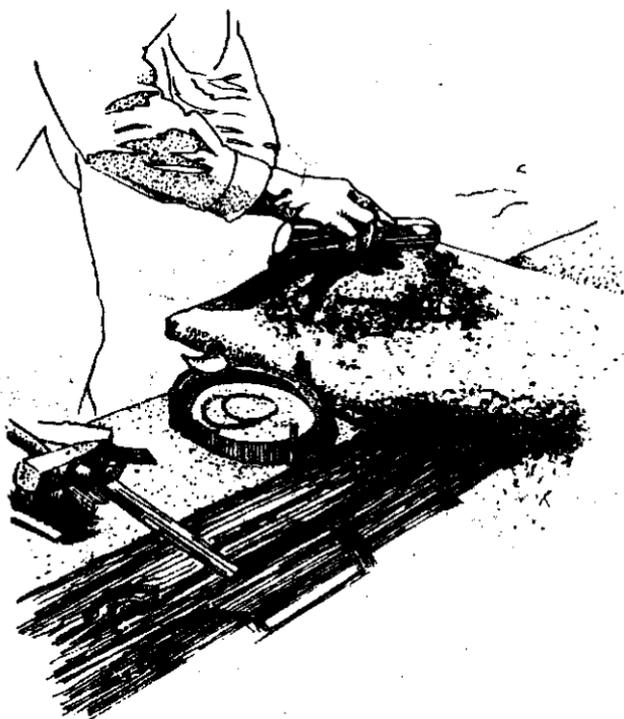
Con la parte cortante del cargador se raya o se hacen destajes cruzados a una profundidad de medio centímetro y se aumenta mas tierra un poco más húmeda que la anterior, y se vuelve a alisarla con el "palo" realizando movimientos transversales a la caja, hasta dejar una superficie de tierra pulida y agradable al tacto.
