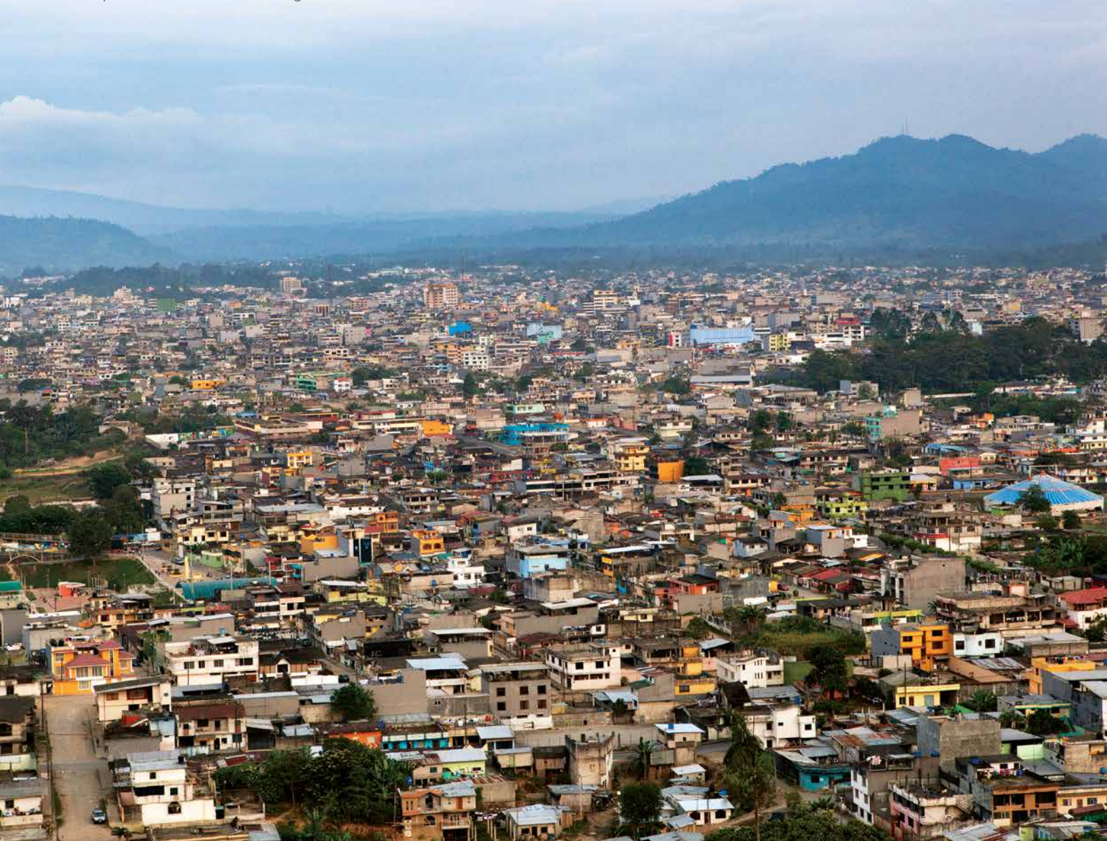
Vista panorámica, Santo Domingo de los Tsáchilas
