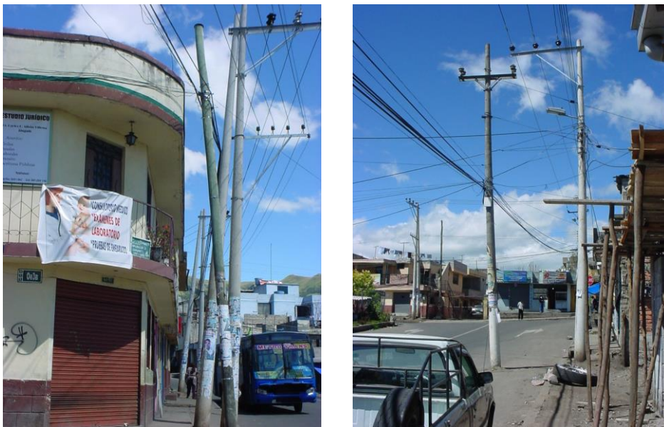
Fig. 22 y 23. La dotación de servicios públicos como el servicio de energía eléctrica existe. La deficiencia está en la calidad del servicio y el abuso del espacio público en el tendido de redes sin importar ni sujetos ni paisaje ni la seguridad pública.
