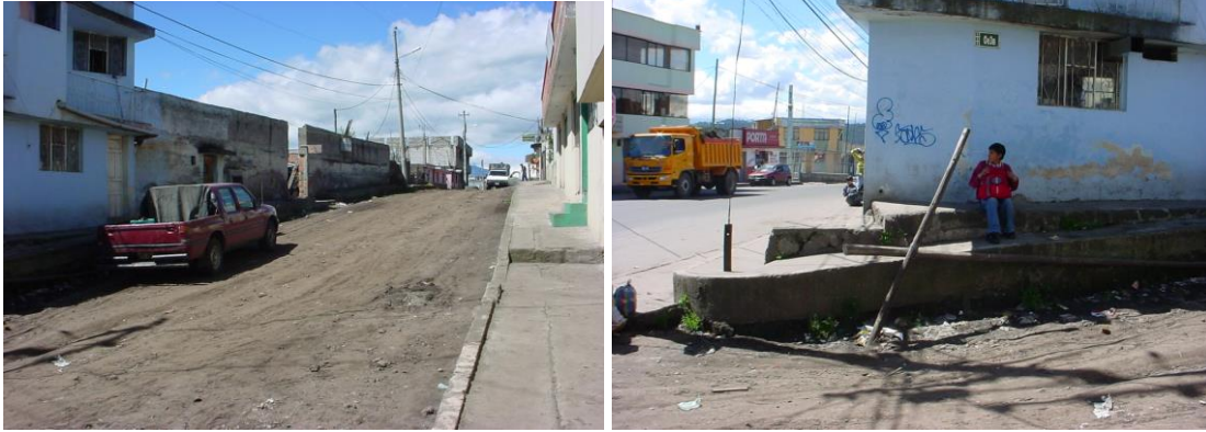
FIG. 20 y 21. Estado de vías, aceras y la calidad de ellas.
