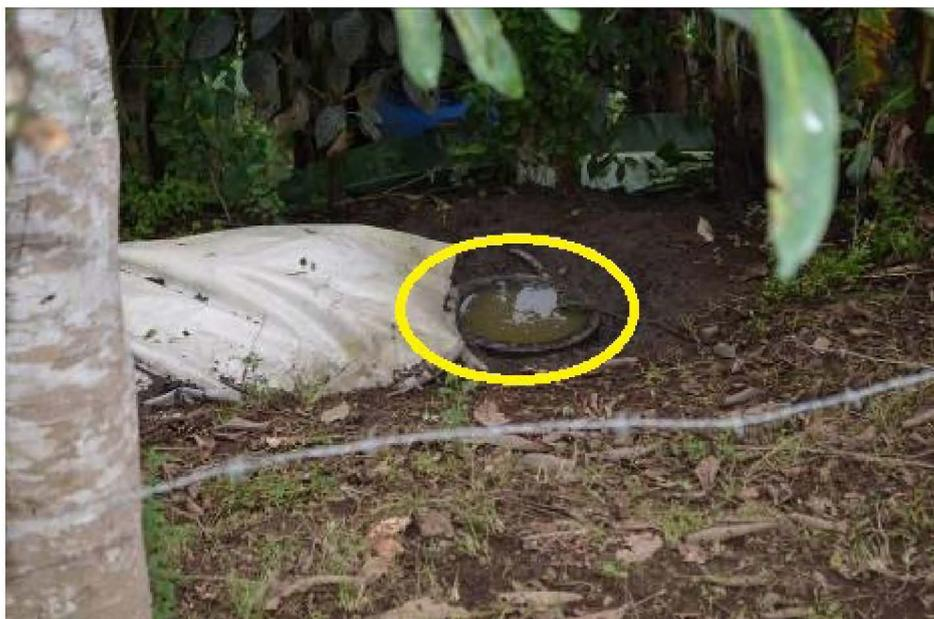
**Fuente:** Elaboración propia (Tanque de carga de los desechos orgánicos al biodigestor)
