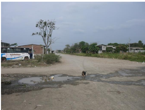
Red vial en mal estado en la zona periférica sur de Rosa María 2
