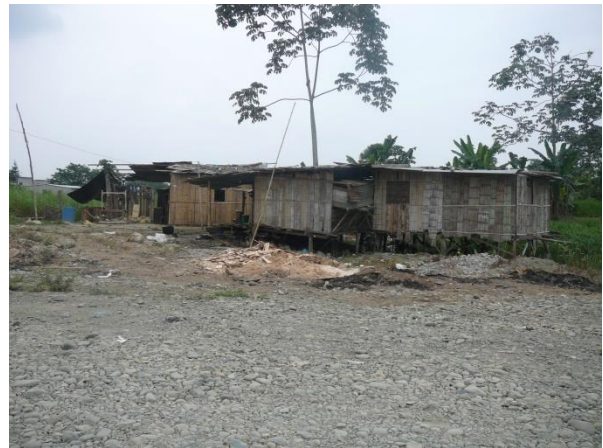
Viviendas en mal estado en Cruz María
