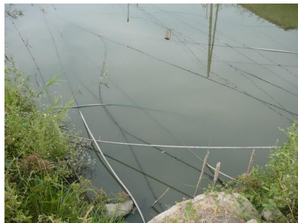
Tubería de agua para consumo en Rosa María 2
