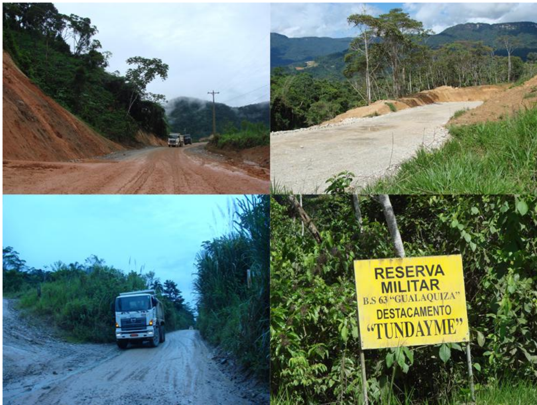
Fotografía 3.4. Ampliación de la vía en Tundayme
