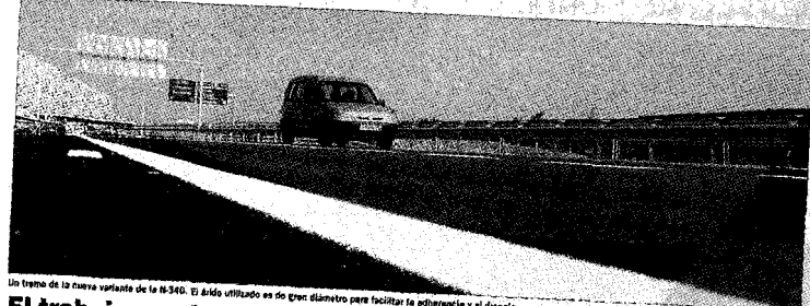
Un tramo de la nueva variante de la N-340. El árido utilizado es de gran diámetro para facilitar la adherencia y el drenaje.
