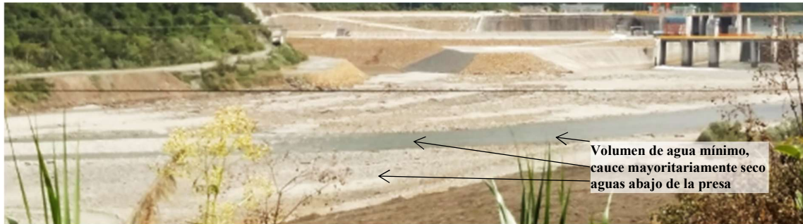
Fotografía 4.9. Río Coca inmediatamente aguas debajo de la captación de CCS. Vista aguas arriba. Fuente: Trabajo de campo
