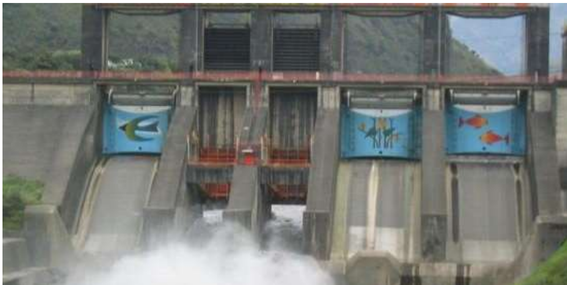
Fotografía 3.4. Vista de las compuertas de la presa. Fuente: CELEC 2016, Información Técnica Agoyán.
