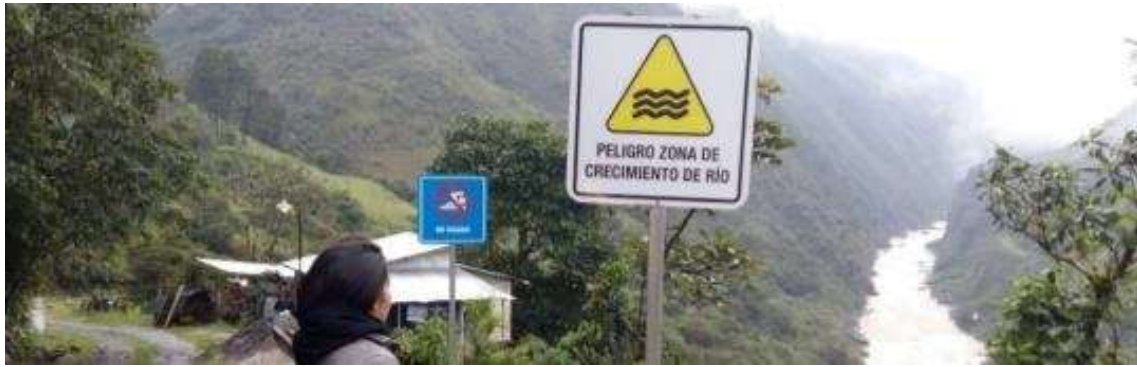
Fotografía 4.18. Señalética prohibitiva ubicada aguas abajo de la presa de Paute Molino.
