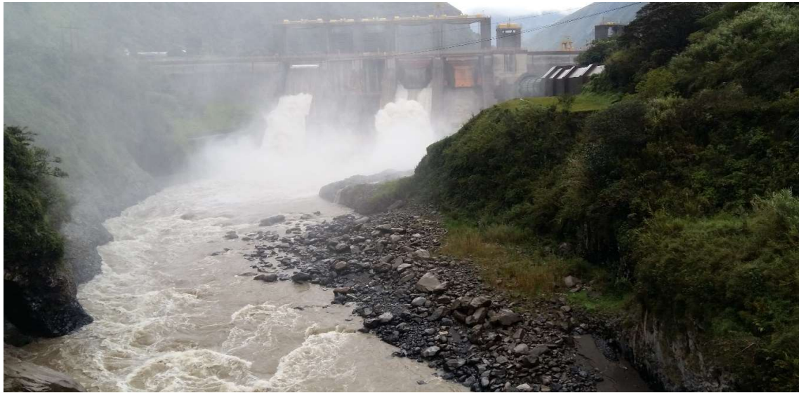
Fotografía 4.19. Presa Agoyán descargando caudales de exceso. Fuente: Trabajo de campo
