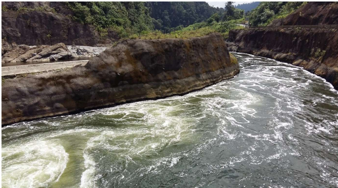
Fotografía 4.35. Descarga de agua de la central Manduriacu en operación (con una sola turbina generando). Fuente: Trabajo de campo
