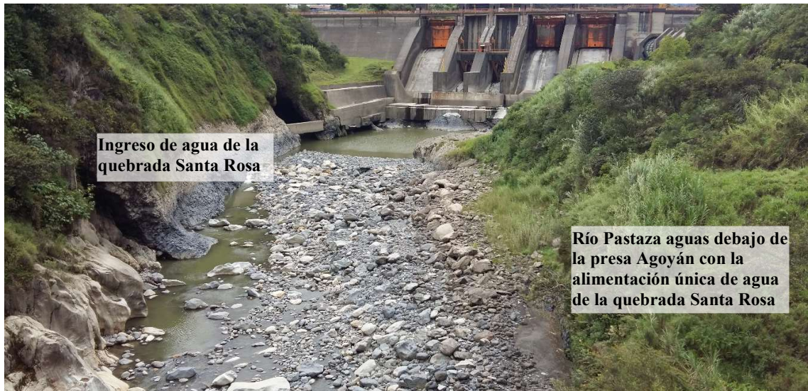
Fotografía 4.23. Río Pastaza inmediatamente aguas abajo de la presa Agoyán que está conteniendo todo el caudal del río. Fuente: Trabajo de campo
