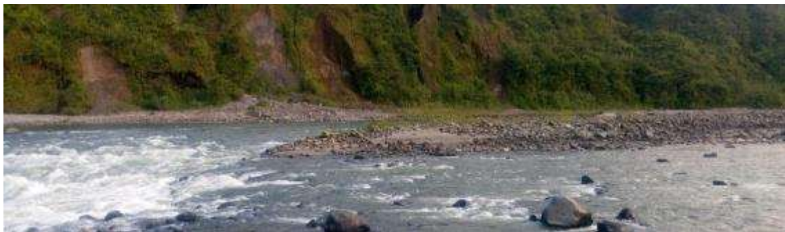
Fotografía 4.6. Río Coca, confluencia del caudal de agua procedente de la descarga del desfogue lateral y de las compuertas de la presa. Fuente: Trabajo de campo
