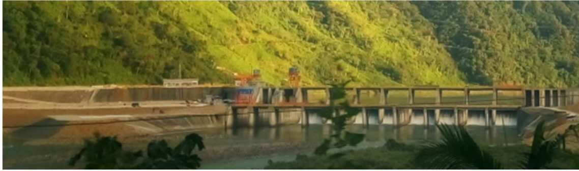
Fotografía 4.4. Río Coca, descarga de agua sobre las compuertas de la presa. Fuente: Trabajo de campo
