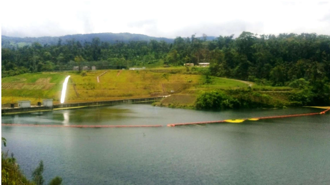
Fotografía 4.42. Embalse con bajo contenido de sedimentos alrededor de dos meses después de lavado completo. Vista hacia la presa. Fuente: Trabajo de campo
