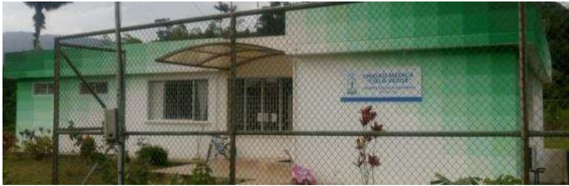
Fotografía 4.46. Construcción de la Unidad Médica Cielo Verde como parte de las medidas compensatorias construidas por CELEC. Fuente: Trabajo de campo
