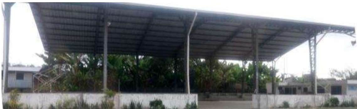
Fotografía 4.47. Techado de las canchas de la Comunidad Cielo Verde como parte de las medidas compensatorias construidas por CELEC. Fuente: Trabajo de campo
