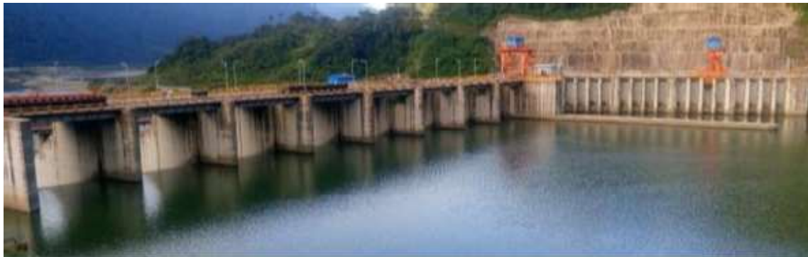
Fotografía 4.3. Río Coca, en la captación de CCS. Fuente: Trabajo de campo
