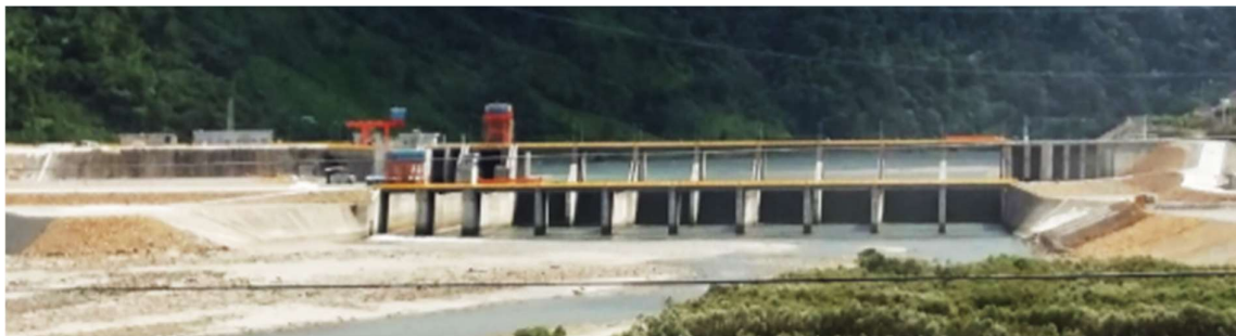
Fotografía 4.8. Río Coca en la captación de CCS. Vista de las compuertas sin descarga de agua. Fuente: Trabajo de campo
