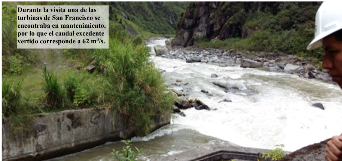
Fotografía 4.26. Vertedero de excesos de la cámara de interconexión (antigua descarga de Agoyán). Fuente: Trabajo de campo
