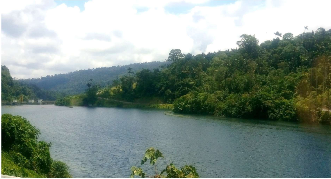
Fotografía 4.41. Embalse con bajo contenido de sedimentos alrededor de dos meses después de lavado completo. Vista aguas arriba. Fuente: Trabajo de campo
