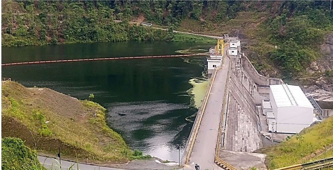
Fotografía 4.43. Embalse con bajo contenido de sedimentos alrededor de dos meses después de lavado completo. Vista superior. Fuente: Trabajo de campo
