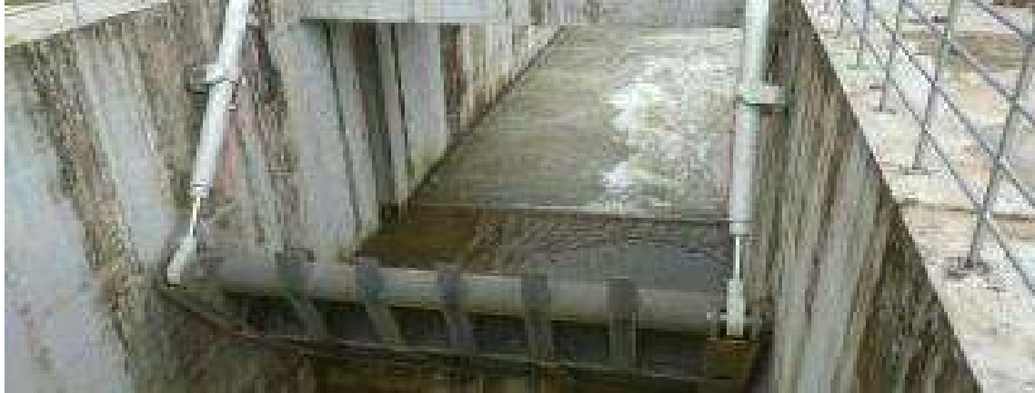
Fotografía 4.2. Desfogue Lateral en CCS. Fuente: Trabajo de campo
