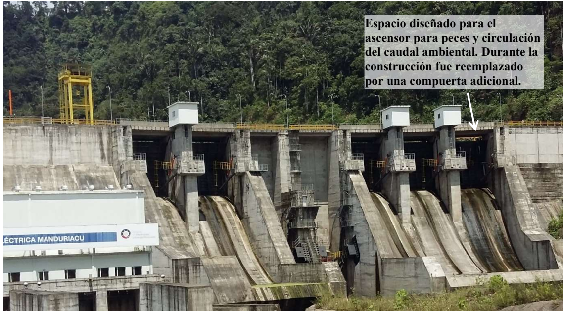
Fotografía 4. 34. Presa de la central Manduriacu con 5 compuertas. Fuente: Trabajo de campo
