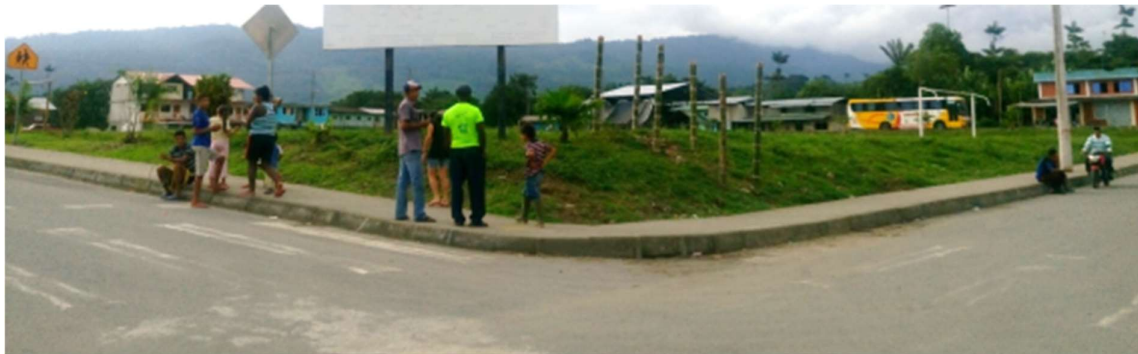
Fotografía 4.45. Asfaltado de las calles perimetrales al parque central de la Comunidad Cielo Verde como parte de las medidas compensatorias construidas por CELEC. Fuente: Trabajo de campo
