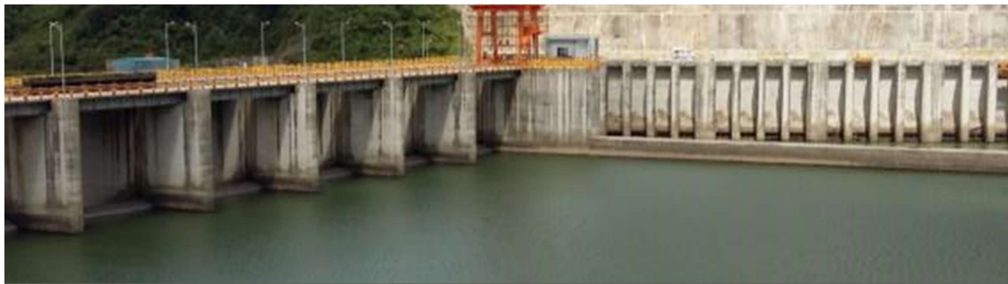
Fotografía 4.7. Río Coca en la captación de CCS. Vista del agua embalsada sin descarga sobre las compuertas. Fuente: Trabajo de campo
