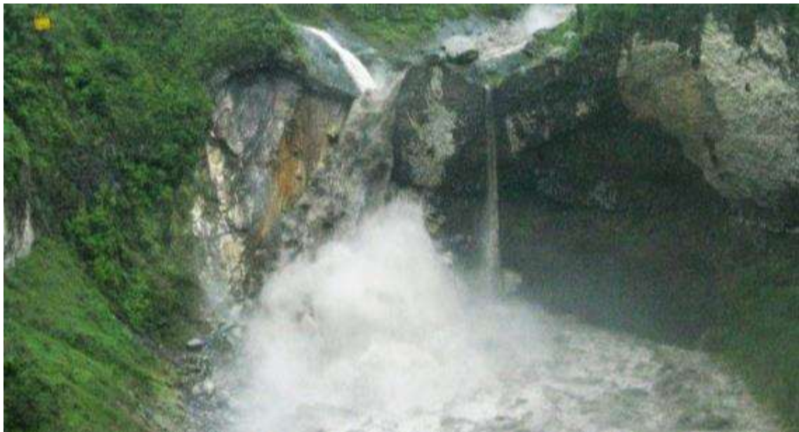
Fotografía 4.28. Vaciado del embalse de Hidroagoyán con agua cargada de sólidos (lodo). Fuente: Trabajo de campo
