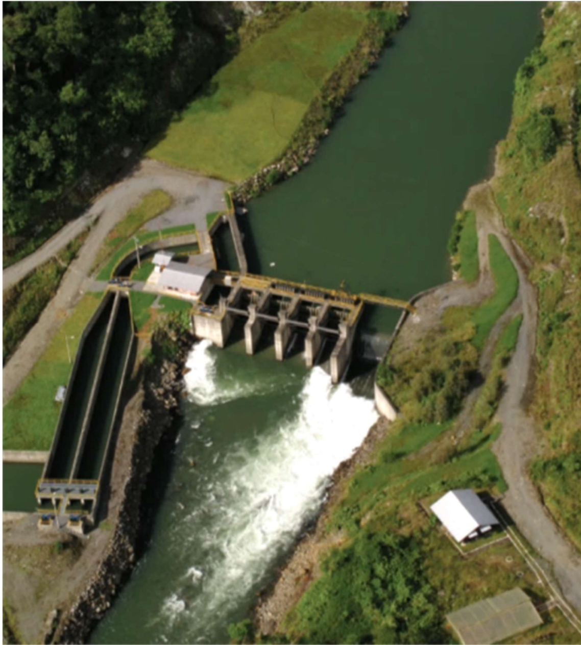
Fotografía 3.6. Hidroabánico. Vista del embalse y de las compuertas. Fuente: Hidroabánico 2015.
