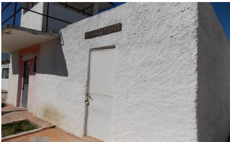
Fachada local Productos de Limpieza – Agosto 2018
