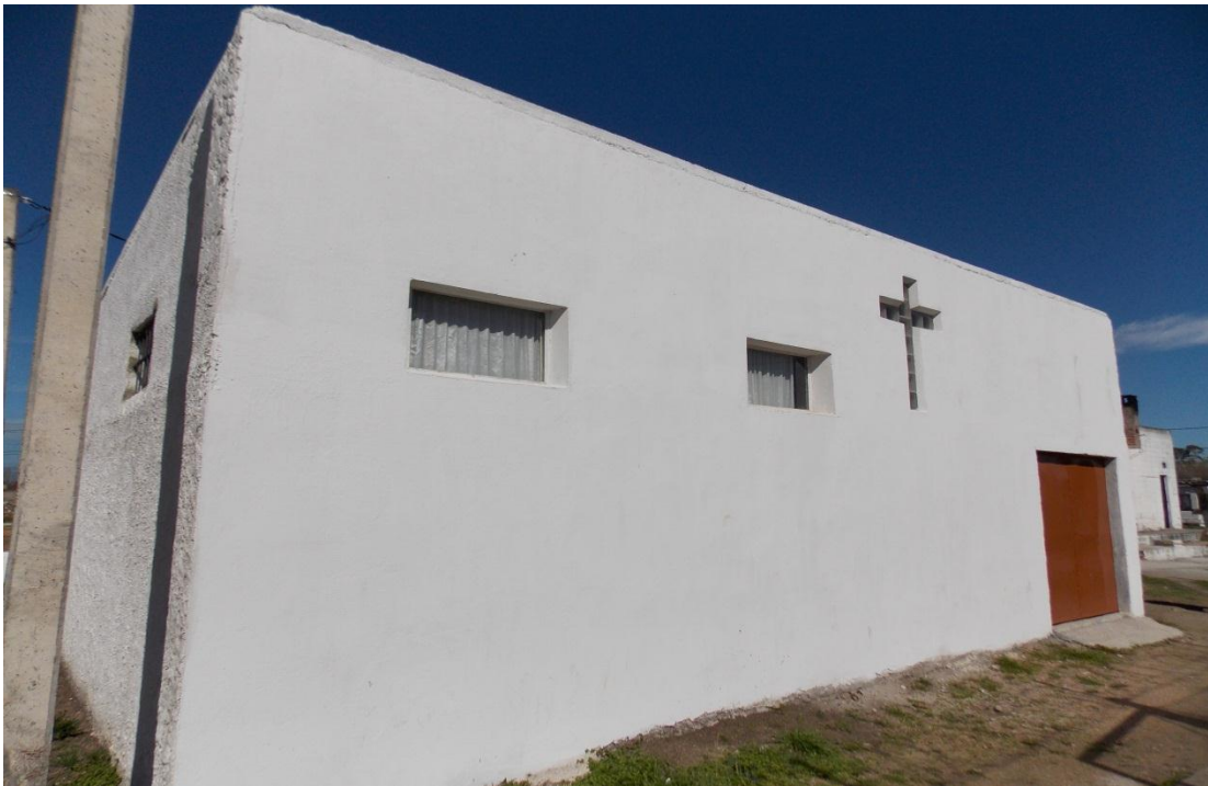
Fachada Iglesia – Agosto 2018.
