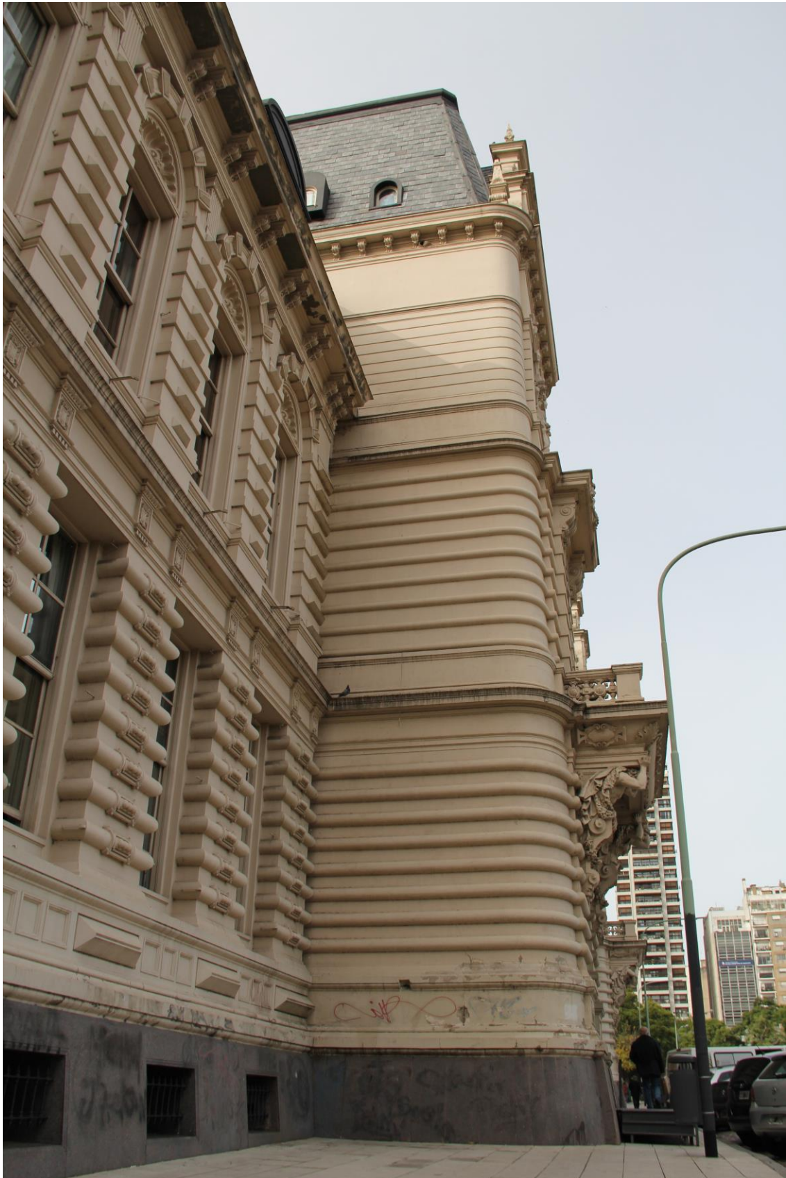
Figura 4. Fotografía actual [Encuentro entre volúmenes]
