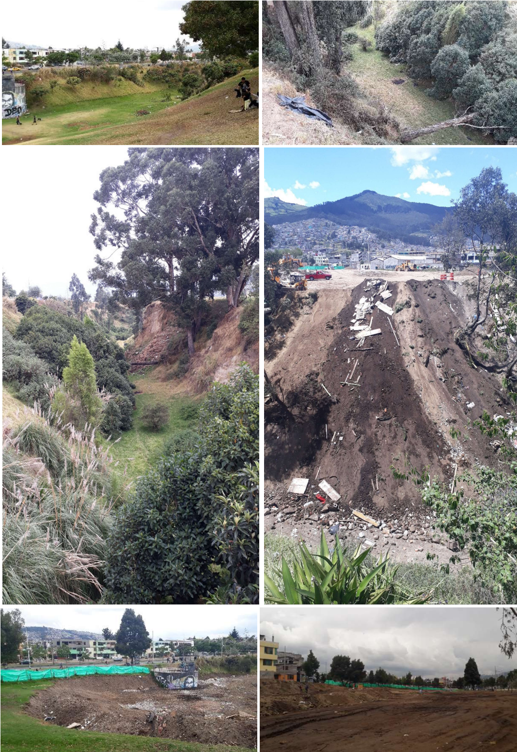
Fotografía 3.9. Quebrada del río Grande, en sus distintos estadios, según el avance de los trabajos de relleno de la misma. Fuente: Trabajo de campo (julio 2018 a febrero 2019)
