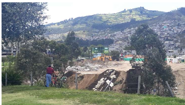
Fotografía 3.7. Designación de la quebrada del río Grande como “escombrera autorizada” por la EMGIRS a partir de noviembre 2018; detalle de los trabajos. Fuente: Trabajo de campo (julio 2018 a febrero 2019)
