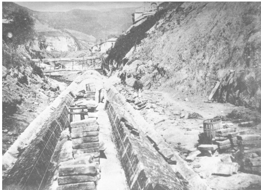
Figura 2.2. Construcción del relleno de la quebrada de los Gallinazos
