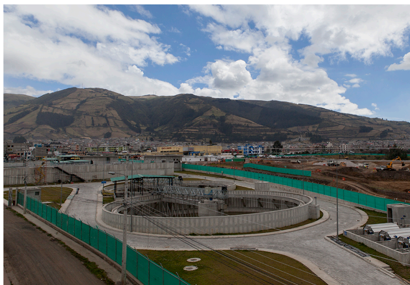
Figura 3.8. Planta de tratamiento de aguas residuales de Quitumbe antes de la finalización de su construcción. Captura en 19 de agosto de 2016. Fuente: trabajo de campo
