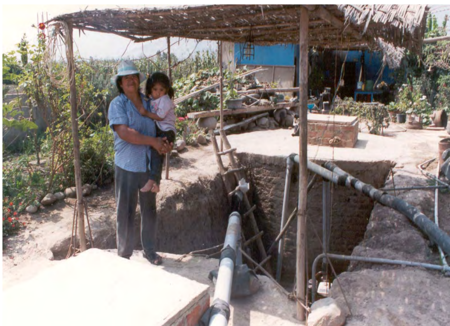
Infraestructura de un pozo subterráneo familiar. Manchay Bajo.
