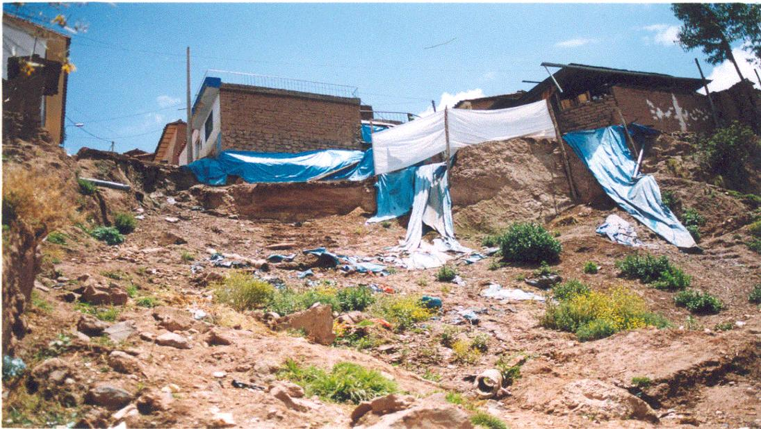
*La amenaza de desastres en la APV Los Incas es latente, vemos que la pendiente del terreno es pronunciada y las viviendas construidas son fácilmente propensas a derrumbarse por el material utilizado y la inexistencia de planes urbanos ni seguimiento técnico.(APV. Los Incas 2003)*
