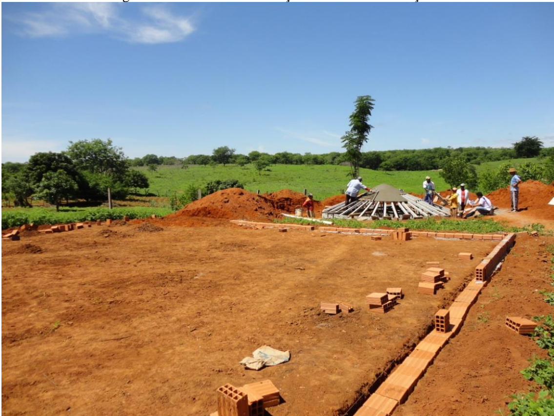
Figura 4 - Processo de construção da Cisterna de Calçadão
