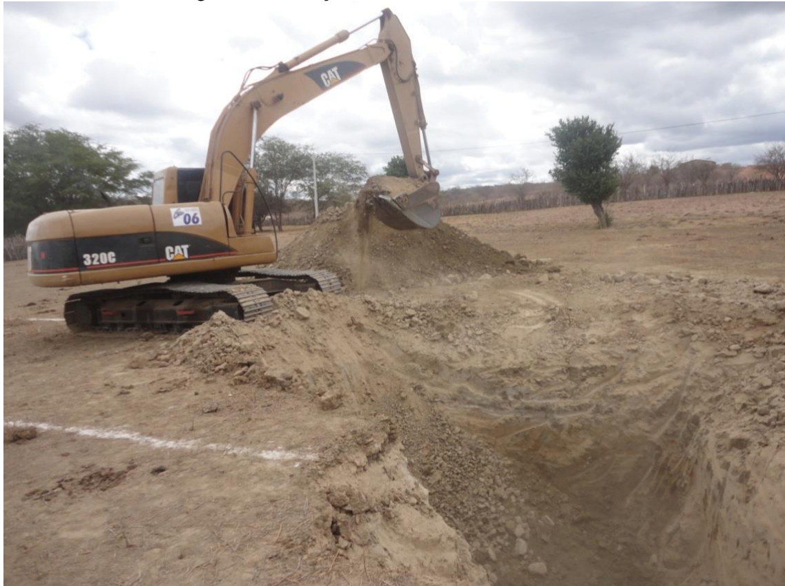
Figura 6 - Escavação do Barreiro Trincheira Familiar
