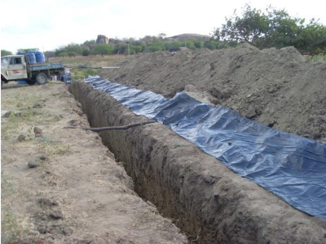
Figura 8 - Acabamento da escavação e preparo para a colocação da lona
