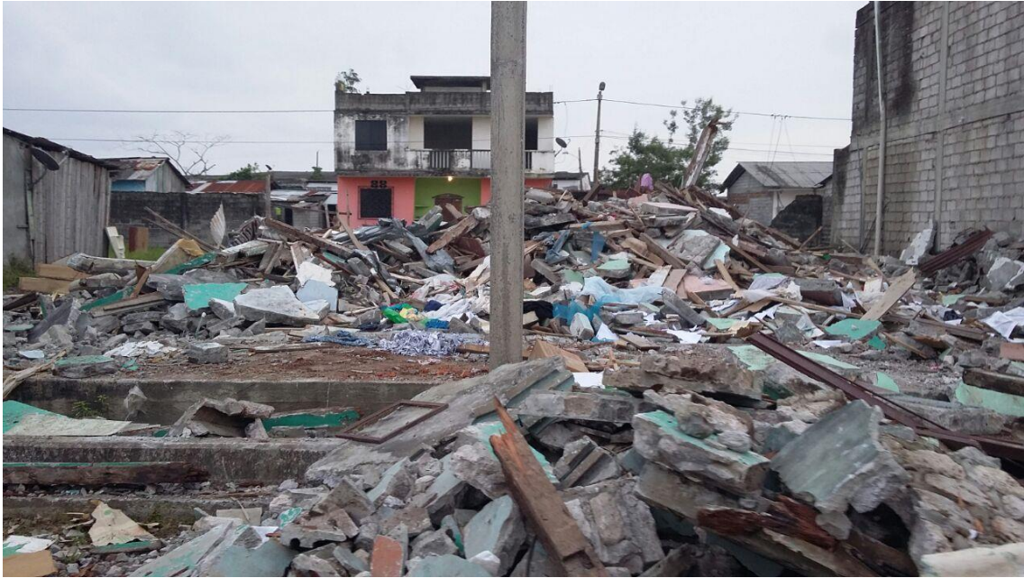
Edificaciones destruidas por el terremoto
