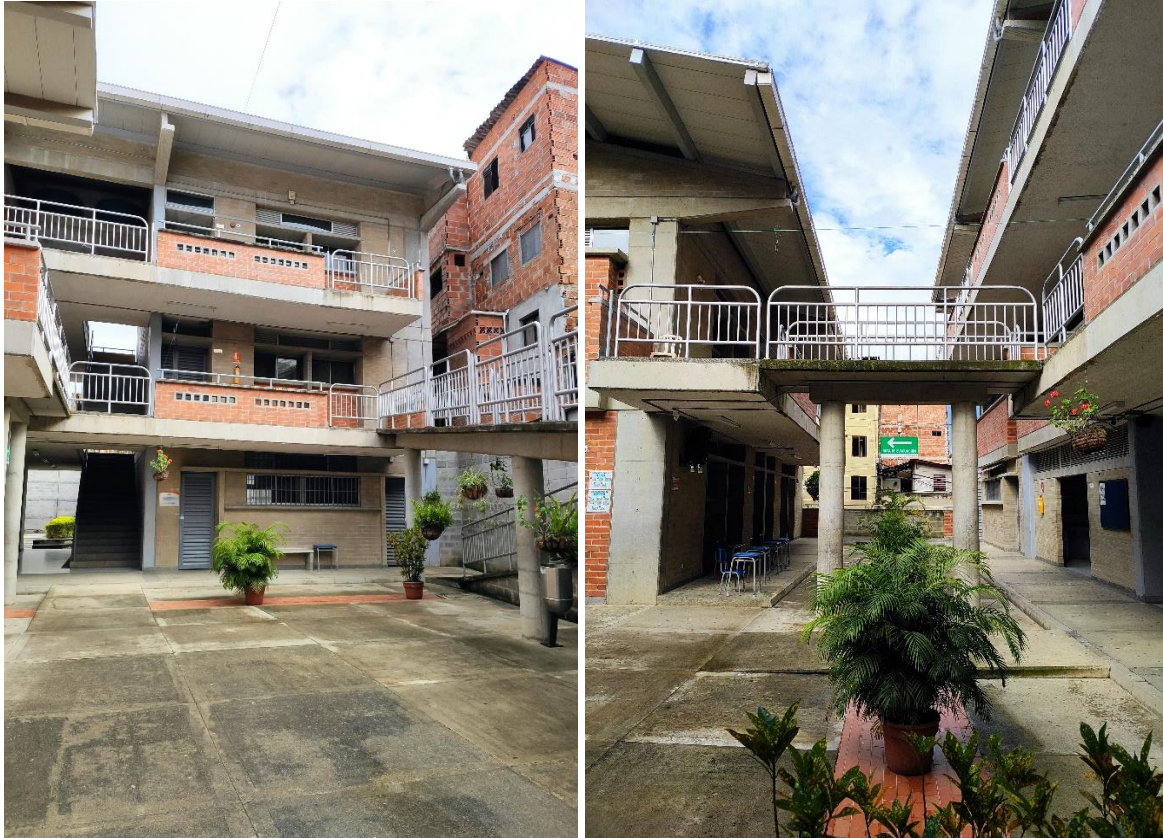
Fotografía 2.6. I.E. La Gabriela sede dos. Fuente: Imágenes tomadas del trabajo de campo.
