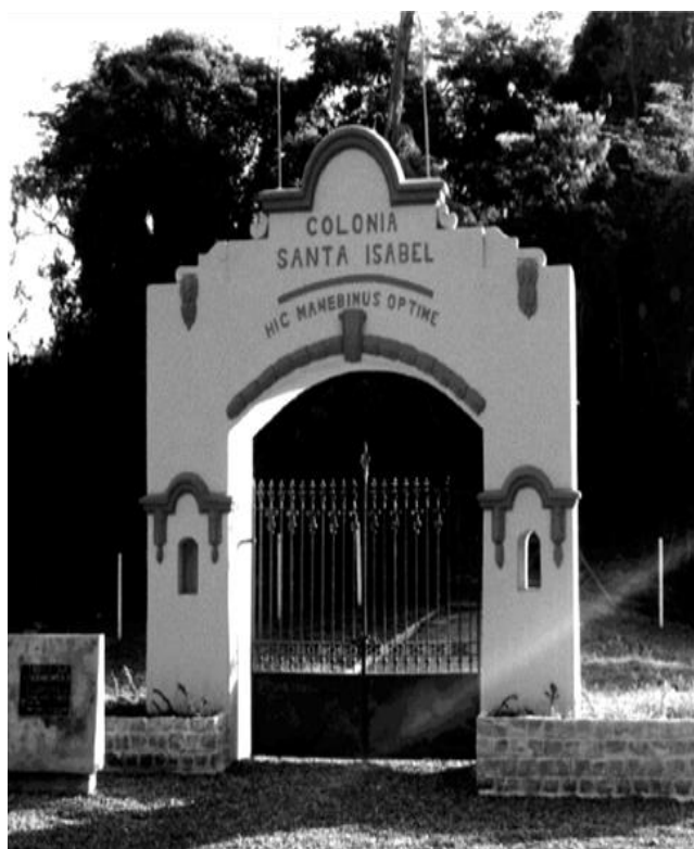
Figura 5 – Único Portal de entrada para a Colônia antes da construção da Rodovia Fernão Dias BR/381 na década de 1940
